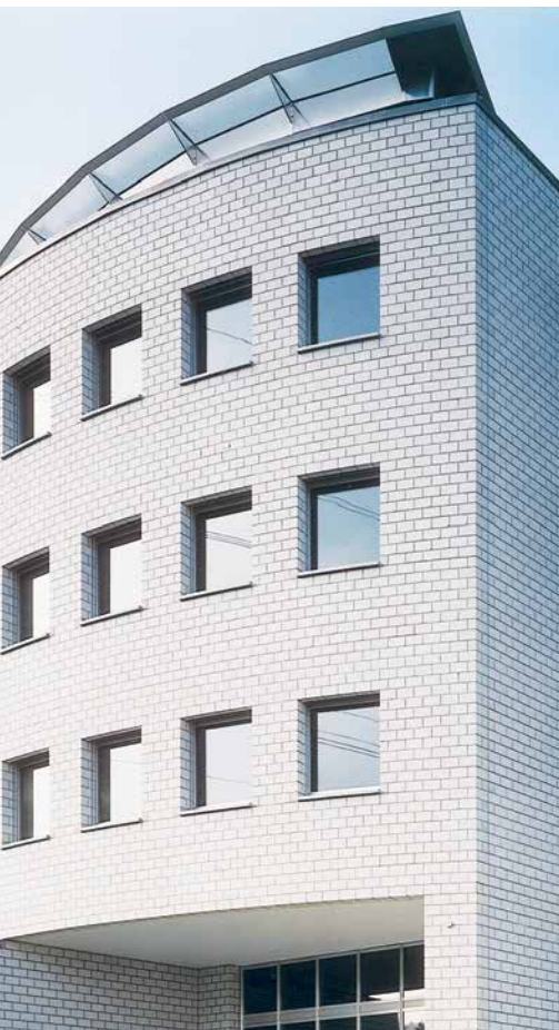
Appareillage en panneresse hauteur de brique 14 cm
