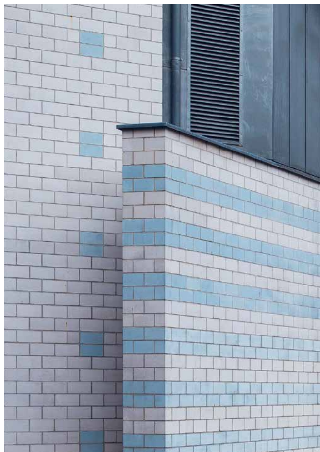
Appareillage en panneresse épaisseur du mur 18 cm
